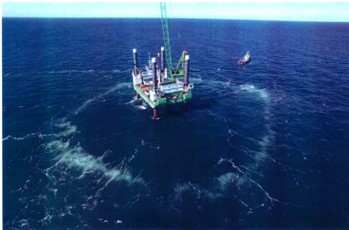
Fotografia 1. Praca kurtyny bąbelkowej podczas budowy morskiej farmy wiatrowej Borkum West II
